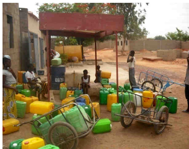
Figure 2 : Les hangars en chantier mais déjà habités par les usagers
