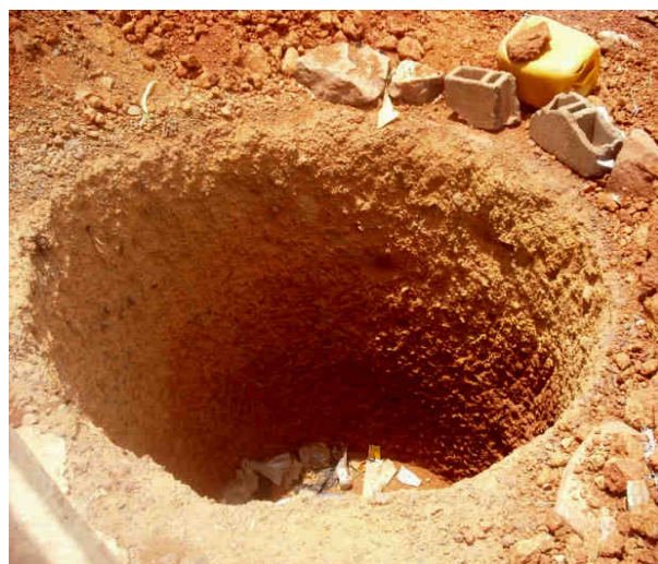
Figure 4 : Puisards en chantier
