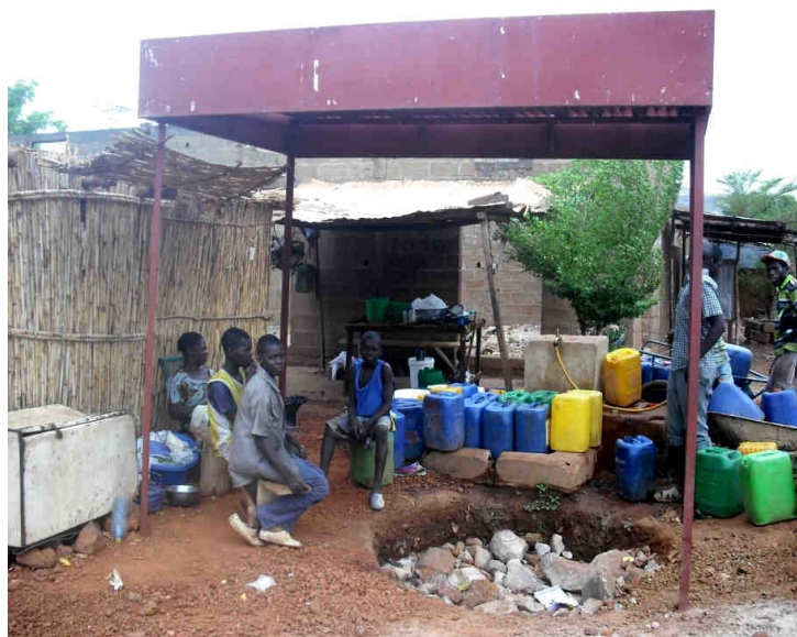
Figure 1 : Début de remplissage d'un puisard à la BF n°3
