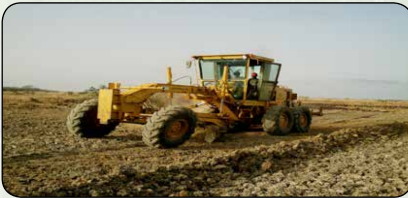
Engin en travaux d'élargissement dans le PNOD en juillet 2013
