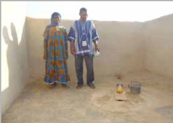
A droite la photo de la latrine de Awa Guindo construite avec les bénéfices des fonds Bio-right
