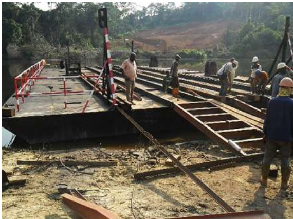
Photo 1: Bac des exploitants forestiers construit sur la rivière Dja en 2014
