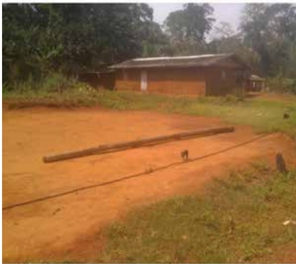
Photo 1: Poteau électrique défectueux dans la FC AFHAN
