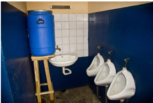
Mécanisme simple de lave-mains, dont le savon est produit localement.
