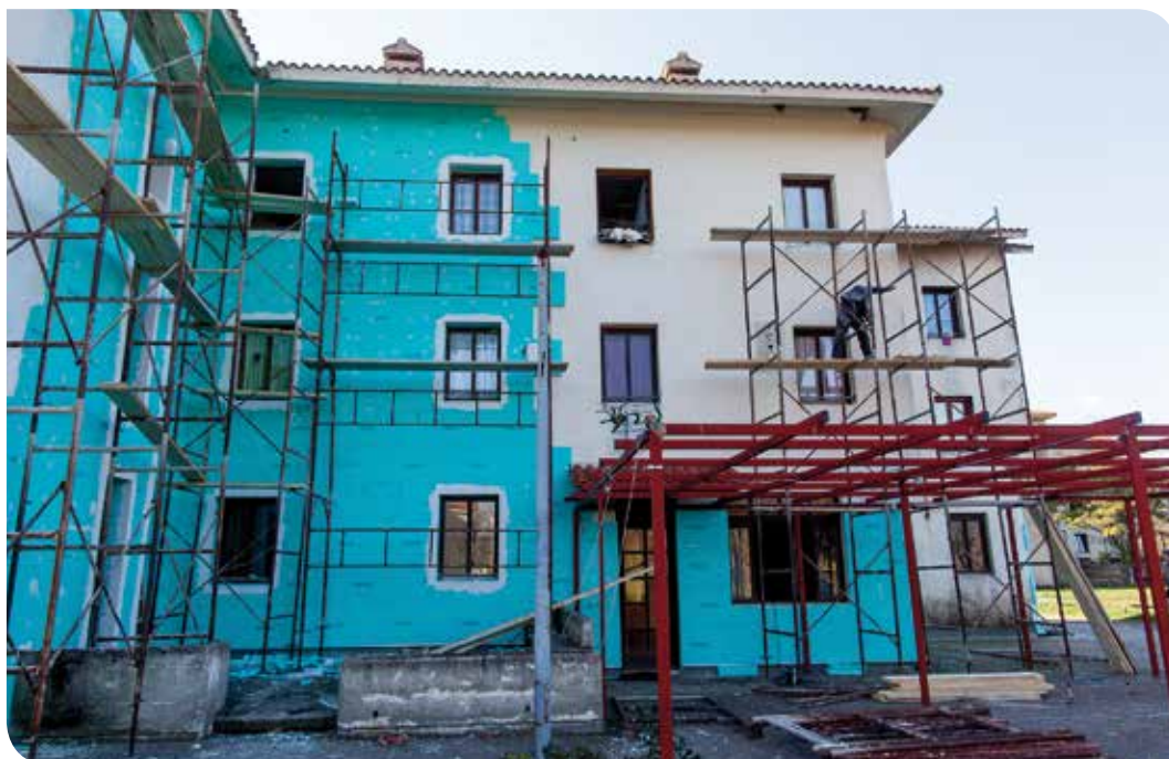
Façade de la résidence étudiante de l'université Démocrite de Thrace (Grèce) en cours d'isolation thermique.
