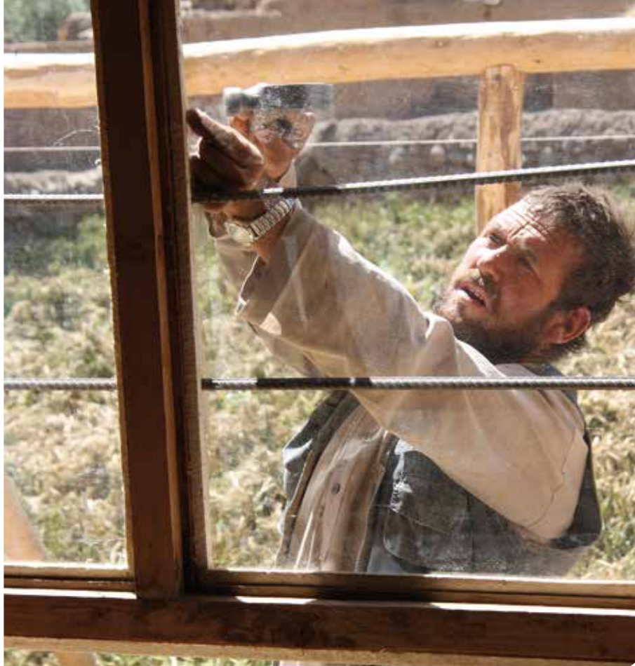
Isolation et pose du survitrage dans une maison afghane.
