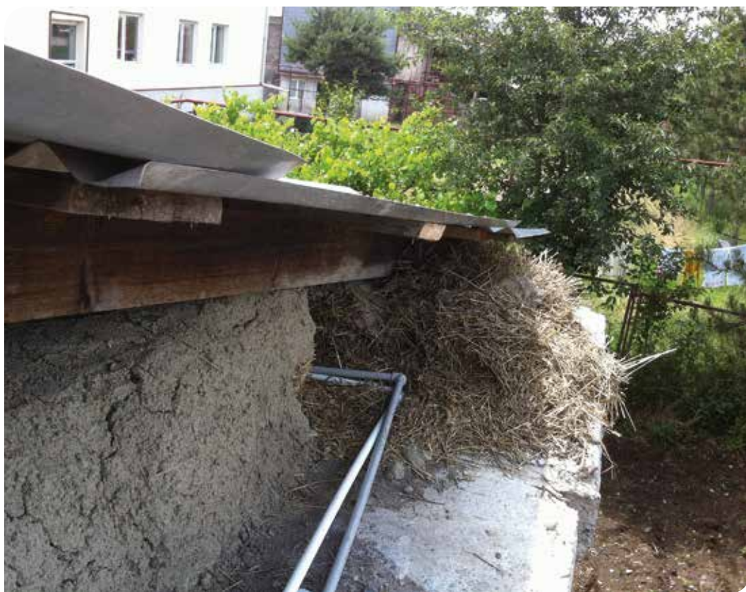
Isolation paille et enduit terre sur le bâtiment de démonstration à Akhaltzikhe en Géorgie.
