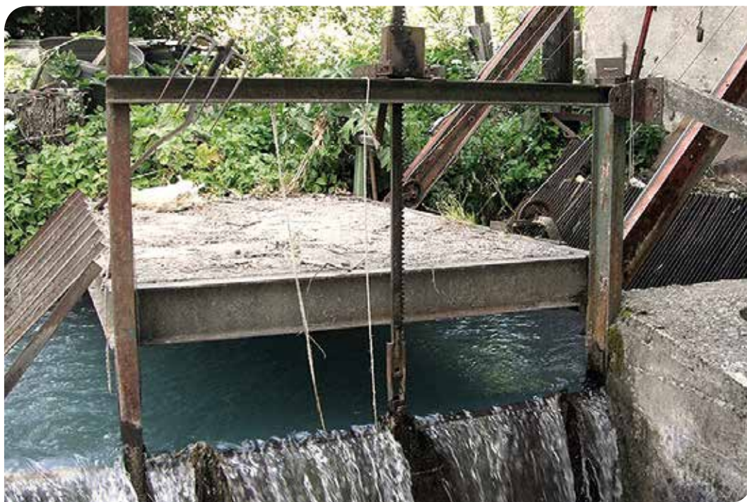
Dégrilleur de la centrale hydroélectrique de Longo Maï à Saint-Chaffrey (05)
