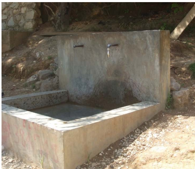
FIGURE 5: EXEMPLE D'UNE BORNE-FONTAINE
