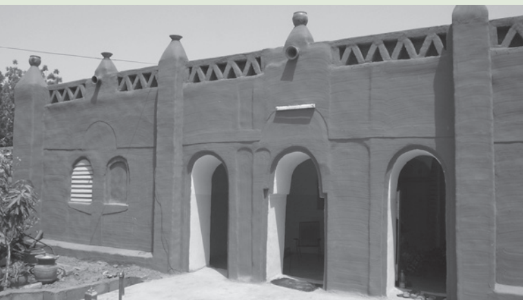
Bâtiment communautaire en voûte nubienne
